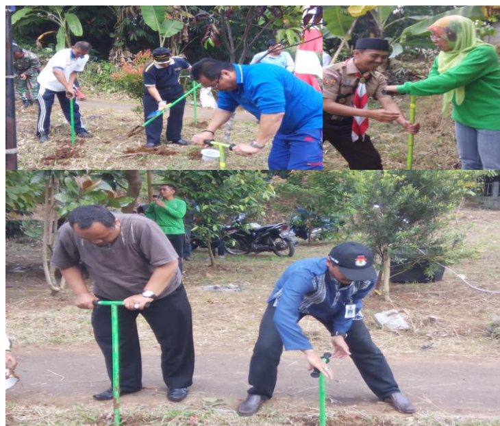
Gambar 4.4. Upaya Pembuatan Lubang Resapan Biopori (LRB)
