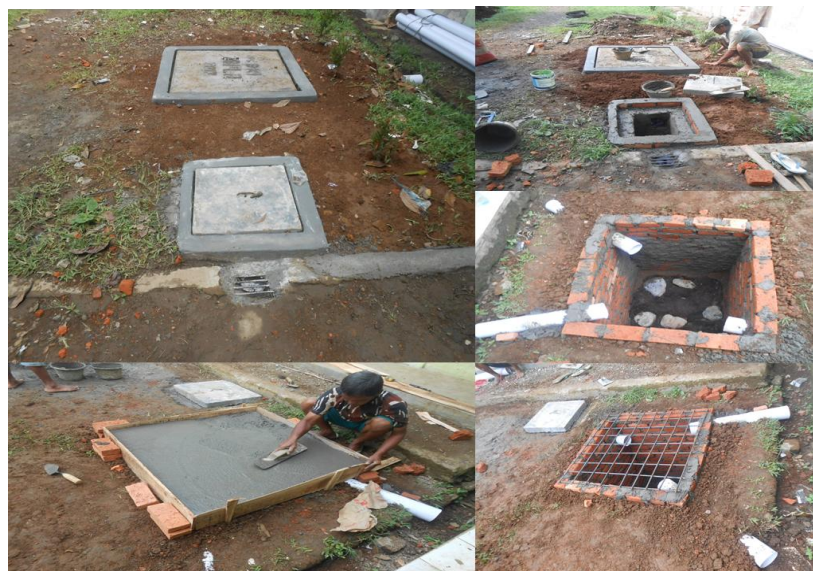
Gambar 4.2. Upaya Pembangunan Sumur Resapan
