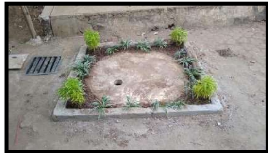
(B) Sumur Resapan di SDN Bantarjati 1 Kota Bogor
